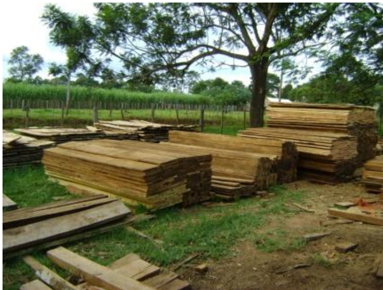
Foto N° 8: Madera aserrada para encofrado.
